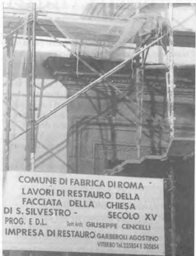
Fabrica - Il portale del Duomo nascosto dalle intelaiature metalliche usate per la tinteggiatura e il cartello della ditta Garberoli appaltatrice del restauro (Foto CAF Fabrica)
