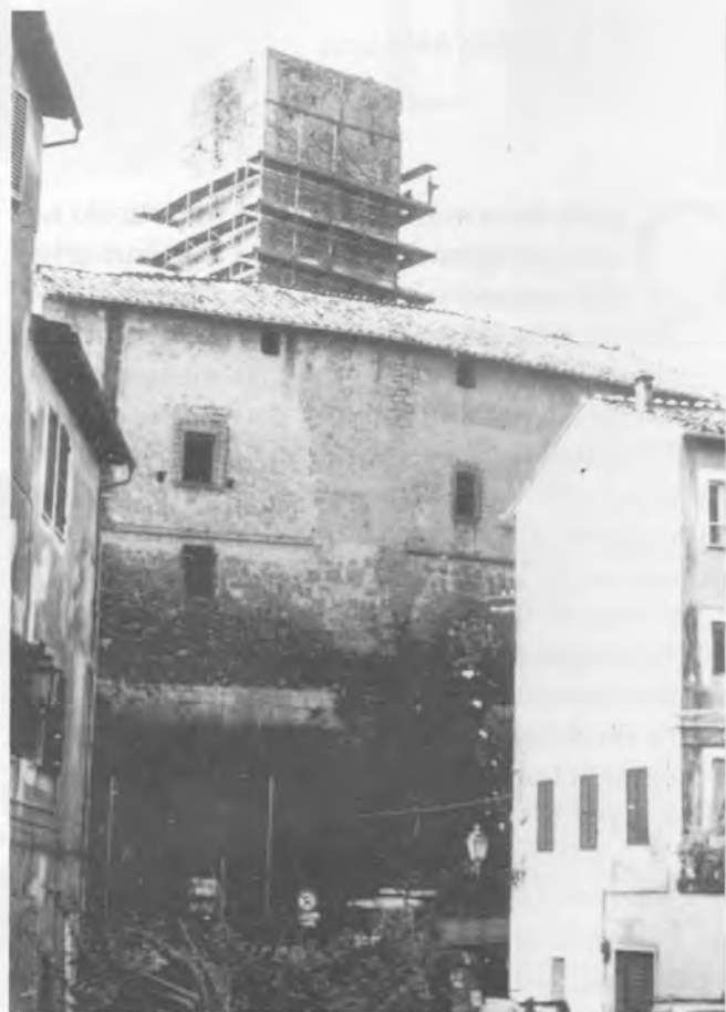
Fabrica - La rocca Farnesiana e la torre stretta dalle impalcature per un restauro conservativo (Foto CAF Fabrica)
